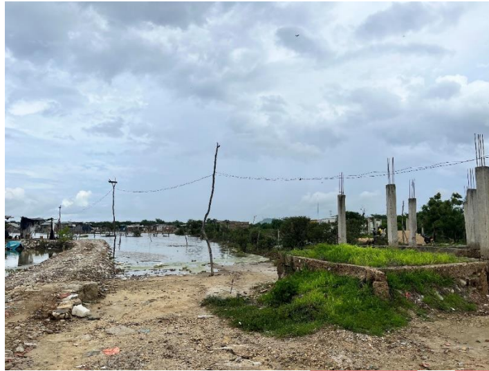
Fotografía: Nuevo Paraíso tomada por equipo técnico
