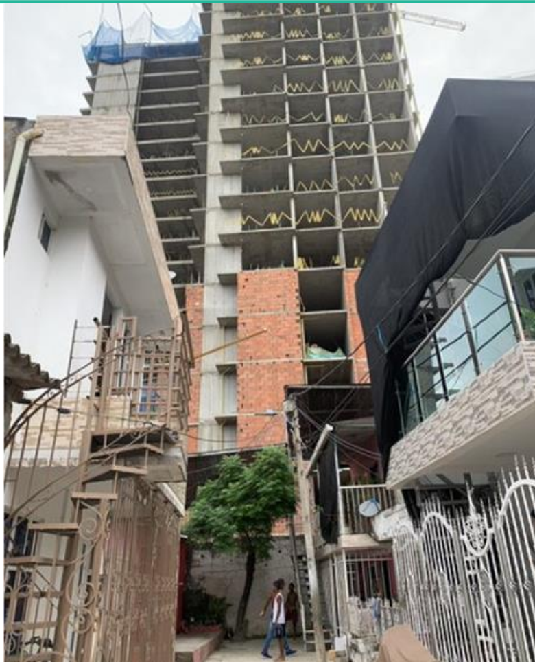
Ilustración 70. Edificación Torices Fuente: Tomada por Equipo de la SDP
